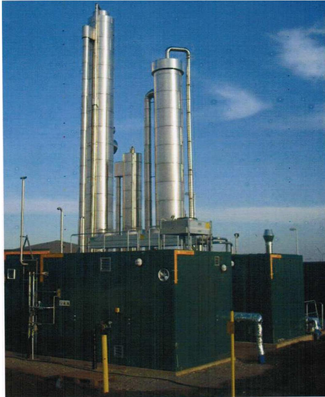
Abbildung 4-3: Druckwasserwäsche mit einer Kapazität von 1.250 Nm<sup>3</sup>/h Rohgas der Fa. Malmberg in Könnern, Sachsen-Anhalt, grüner Container im Vordergrund GDRM-Station (Foto Malmberg)
