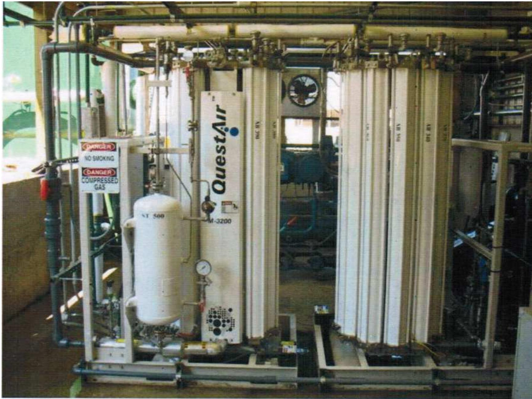
Abbildung 4-9: PSA-Anlage Typ M-3200 (Foto: QuestAir Technologies Inc.)
