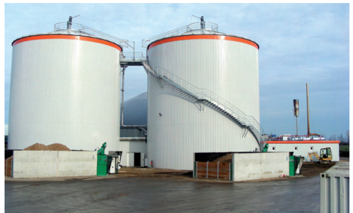
Abb. 5: Zwei Hochfermenter mit Feststoffeintragstechnik
