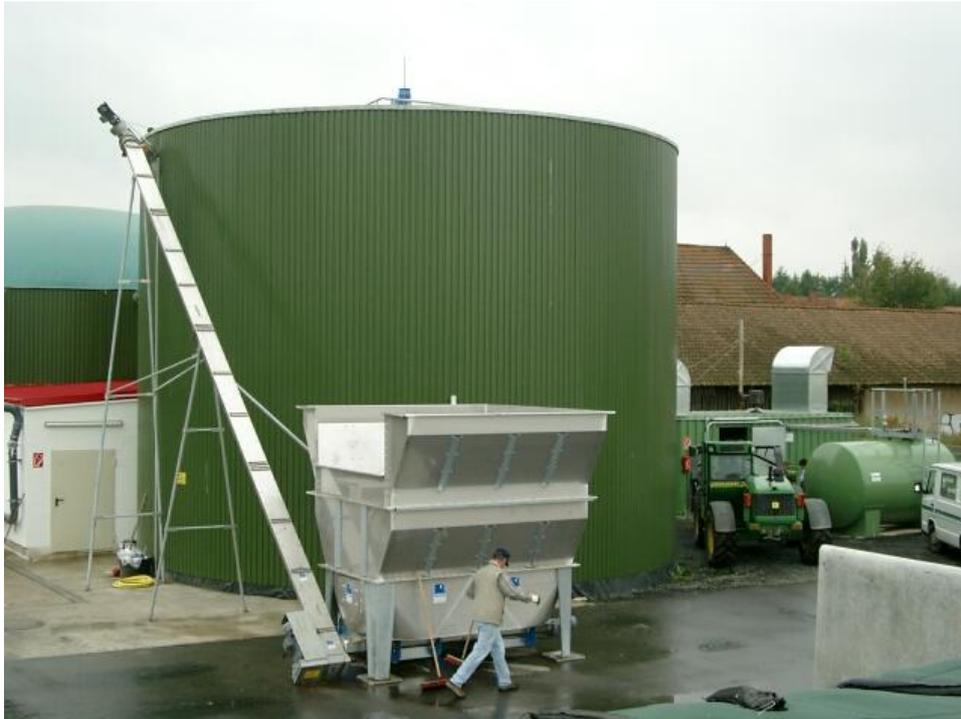
**Abb. 3:** Feststoffeintragstechnik in den Fermenter
